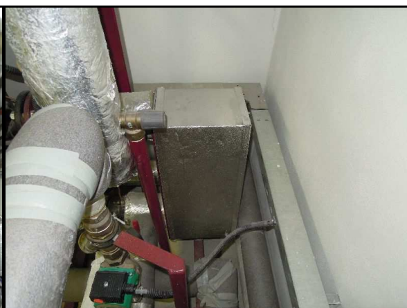
Deskový výměník pro přípravu TV v místnosti 0.12
